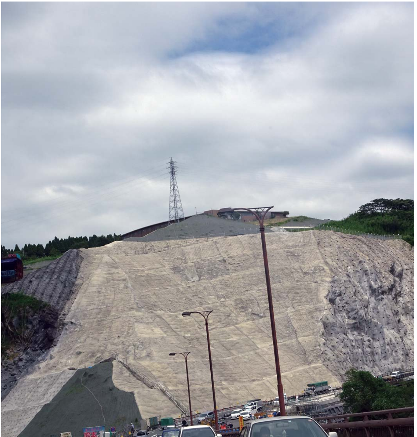
復旧工事が進む阿蘇長陽大橋付近の枋の木地区（熊本県阿蘇郡南阿蘇村河陽）
