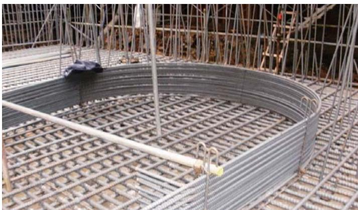
建物の形状に応じて加工された鉄筋
